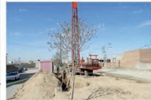
اجرای عملیات حفر چاه عمیق شهرک امام حسن (ع) در راستای تامین آب شرب پایدار اعتبار: ۱۵ میلیارد ریال
